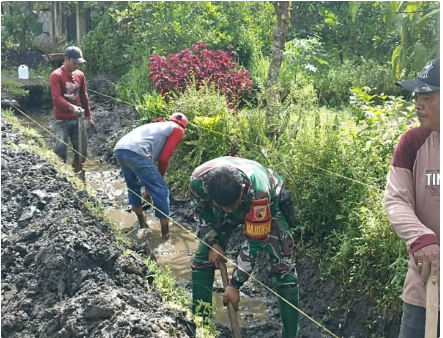
JEMBER – Warga Dusun Krajan Desa Rowosari Kecamatan Sumberjambe Kabupaten Jember melaksanakan Kerja bakti pembangunan plengsengan saluran irigai, sepanjang 200 meter, dalam mengoptimalkan irigasi pertanian. Rabu 29/01/2025.
